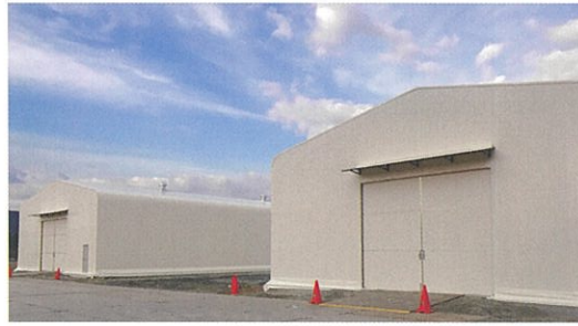
施工例：テント倉庫
