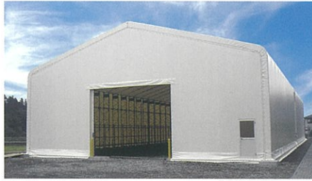
施工例：テント倉庫
