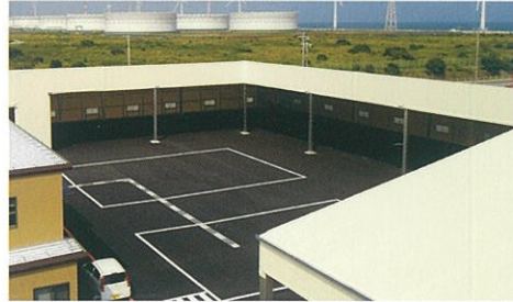
施工例：工場荷捌き場
