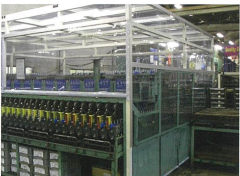
ビニールブース (スチールフレーム)
