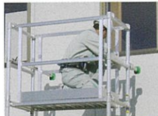
(A) 床付き布わくも、部分開閉式として、より安全性を確保しました。
