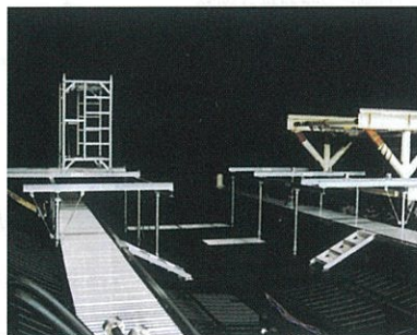
宇宙開発事業団(筑波宇宙センター) 人工衛星試験支援設備
