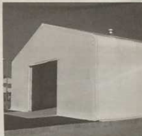
大型テント倉庫
